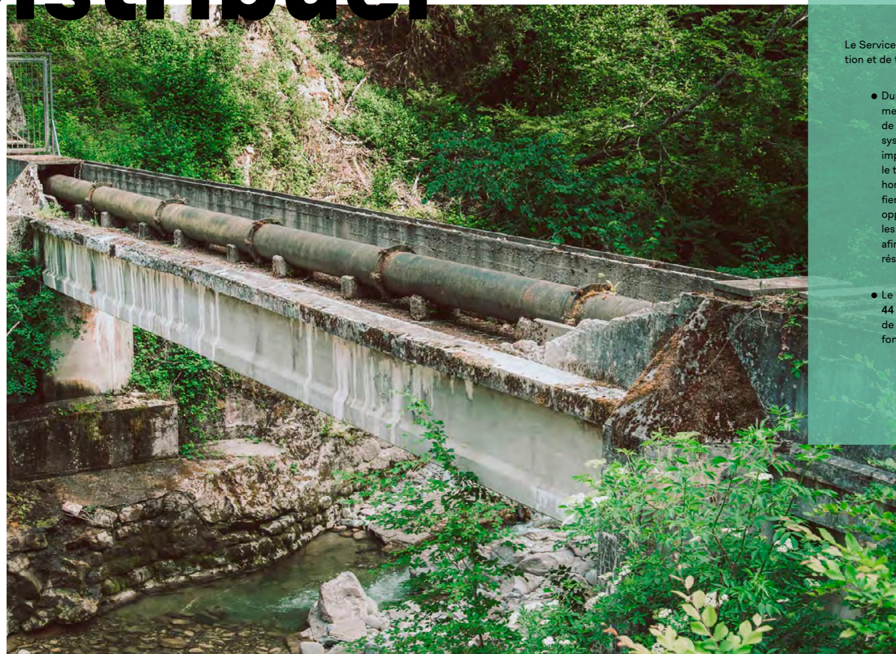
Chantier du Pont de Fenil, le cours de la Veveyse, Saint-Légier.
