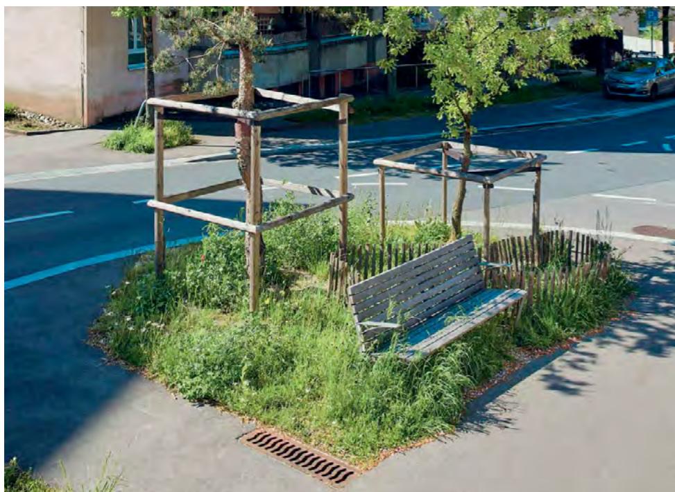
Une fosses à impluvium, à l'avenue de Montoie.
