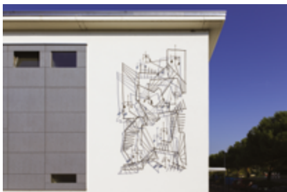
Station électrique de Vidy Chemin du Bois- de-Vaux 46 Façade est
