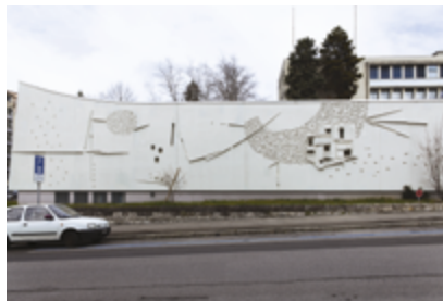
Collège de Béthusy Rue Mathurin- Cordier 10 Façade sud de l'aula
