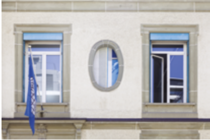
Avenue de la Gare 12 Fenêtres
