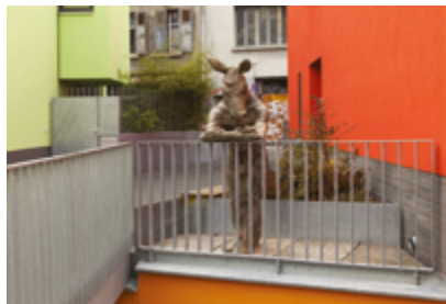
Passerelle de l'îlot b' Au-dessus de la Rue du Flon Accessible depuis la Rue du Rôtillon
