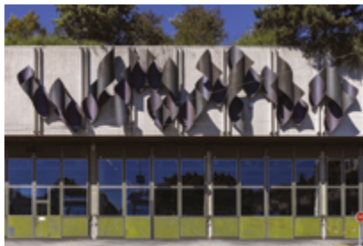
Entrepôt des TL Rue de la Borde 77 Fronton sud
