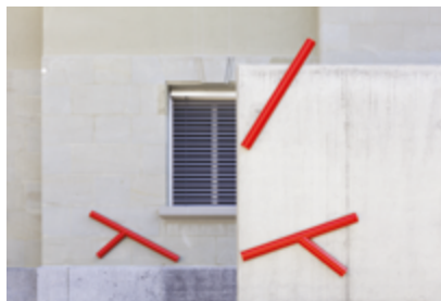
Collège de Villamont Ch. des Magnolias 6 Préau
