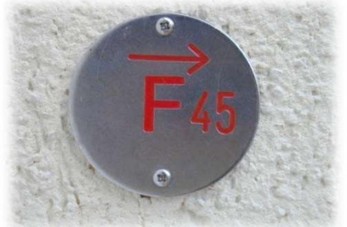
Pose de la plaquette de rappel uniquement avec accord_Police du feu
