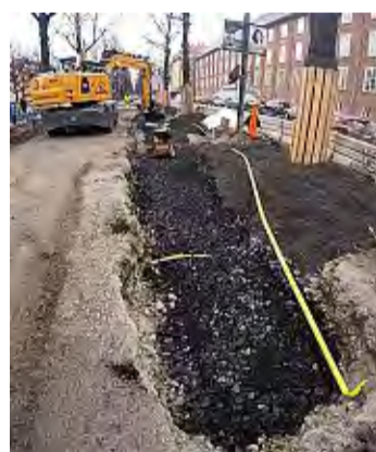
Le «biochar» permet de retenir la pluie dans les sols et de stocker du CO 2 . Ici dans les rues de Stockholm.
