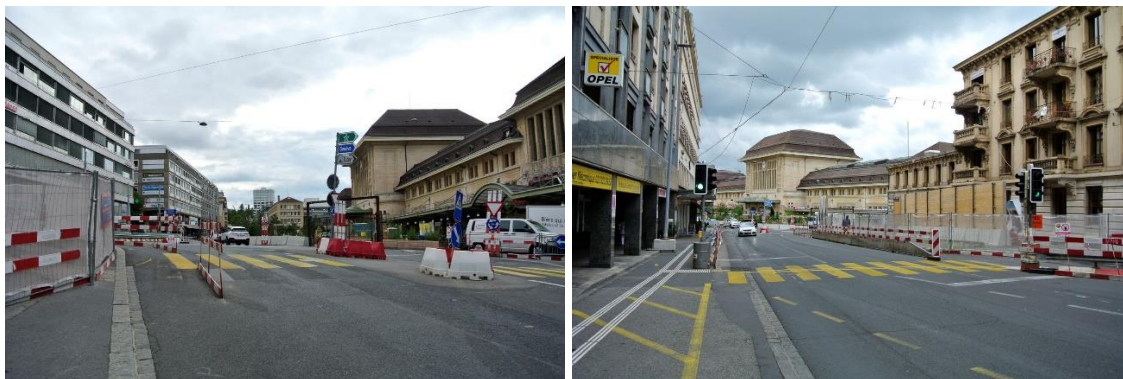
Avenue Louis-Ruchonnet, direction les arrêts de bus : zones étroites et/ou en travaux (photos : laoulia)
