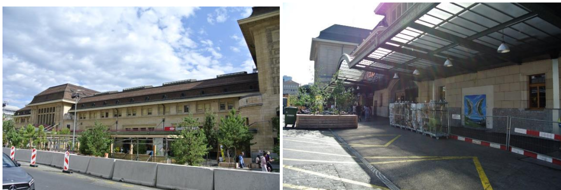
Blocs de béton entre l'avenue et la place (photo droite) et barrières métalliques au niveau de la zone de livraison (photo gauche) (photos : laoulia)
