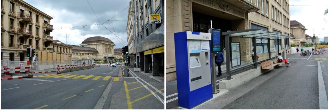
Trottoir en travaux vers les arrêts de bus de l'avenue de la Gare (photos : laoulia)
