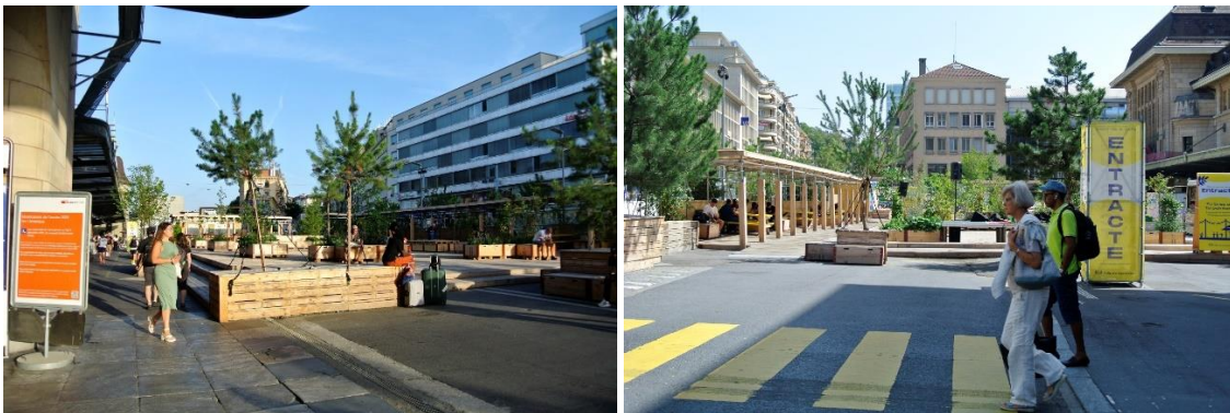
Espaces de circulation axe central classique : enrobé et dallage (photos : laoulia)
